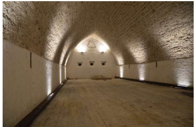
Salle haute de la poudrière, avec sa voûte en berceau brisé
